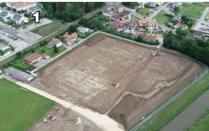
1 La première phase dans la réalisation d'un terrain de foot en gazon artificiel est de créer une plate-forme dont les caractéristiques de planéité, de portance et de stabilité dans le temps sont compatibles avec une telle réalisation. En effet, la moindre déformation du sous-sol sera visible en surface et peut dans certains cas mettre en cause l'utilisation même du terrain.
