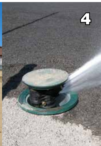
4 Test du système d'arrosage avant la pose de la couche de support. L'arrosage permet de gérer la température du revêtement lors de fortes chaleurs.
