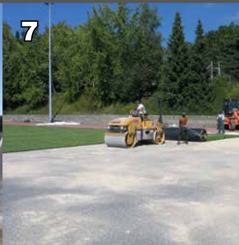
7 Les tapis sont déroulés et posés à même la couche de support, ou sur la couche de souplesse.
