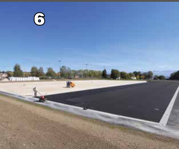
6 Réalisation de la couche de souplesse coulée ou préfabriquée, nécessaire pour certains systèmes Realsport.
