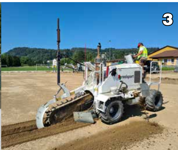
3 Le système de drainage sera étudié pour permettre d'évacuer les eaux de surface rapidement vers l'exutoire, le terrain est ainsi jouable par tous les temps.
