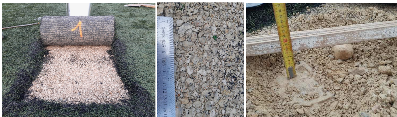
Sondage S1 : Découverte de la surface de la fondation – aspect de surface de la fondation – mesure de l'épaisseur de la fondation (= profondeur de la tranchée drainante).
