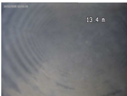
Drain 4 – retenue d'eau importante entre 11 et 22m – drain généralement propre.
