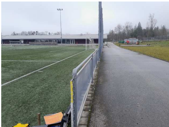
Lice métallique fermée par un grillage – bordures en pavés de béton – caniveau sur les deux longueurs du terrain.
