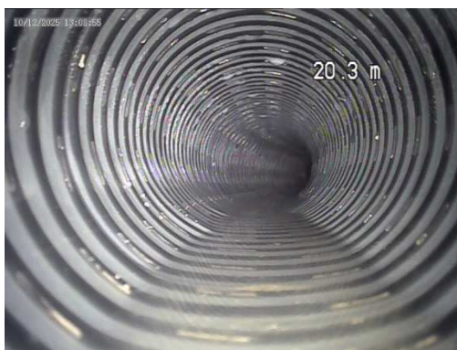
Drain 11 : Dépôt de fines – légère retenue d'eau et changement de direction du drain.
