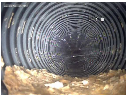
Drain n°1 : dépôt de fines à l'entrée du drain – exemple de retenue d'eau (contre-pente) à 7,6 m.
