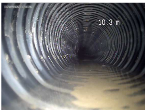
Drain 11 : Dépôt de fines – légère retenue d'eau et changement de direction du drain.
