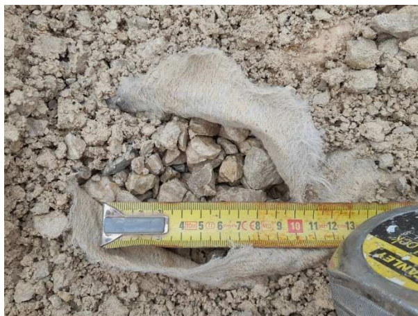
Sondage S1 : ouverture de la tranchée drainante (fermée en surface par un géotextile, remplie avec un matériau concassé calcaire de type 10/14 à 10/16 mm).
