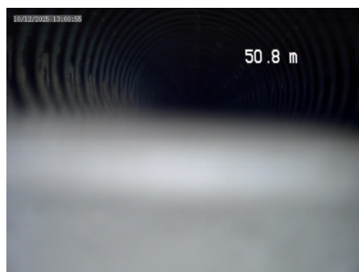
Drain 8 – Quelques retenues d'eau et dépôt de fines.
