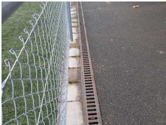
Lice métallique fermée par un grillage – bordures en pavés de béton – caniveau sur les deux longueurs du terrain.
