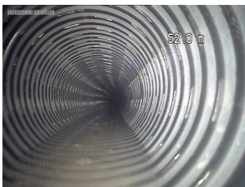
Drain 4 – retenue d'eau importante entre 11 et 22m – drain généralement propre.
