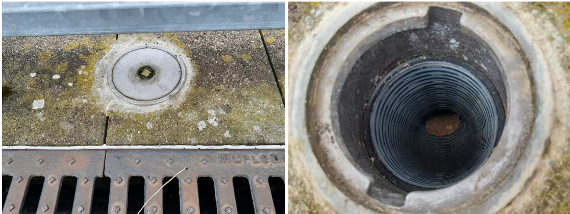
Vues sur une pipe de curage.
