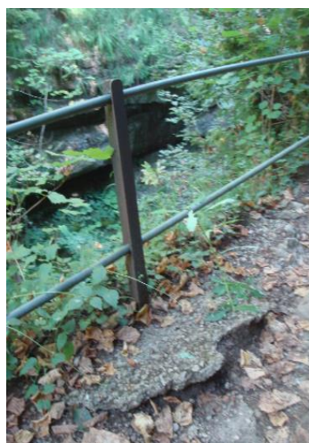
Image 3 : Fondations apparentes et grand écartement des éléments horizontaux
