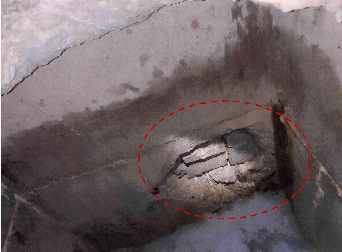
*Structure béton cassée avec infiltration d'eau*
