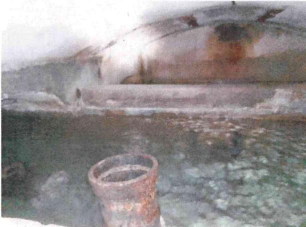
*Bassin de traitement : moisissures, taches indéterminées, rouille..., accès direct à l'eau, air non filtré, ouvert sur le reste du bâtiment.*
