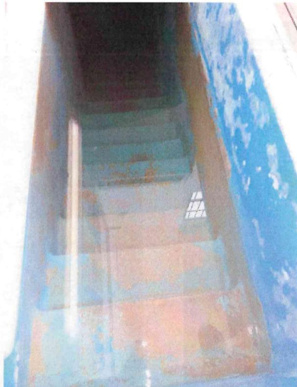
*Le revêtement des cuves d'eau potable s'effrite, transmission de substances à l'eau.*
