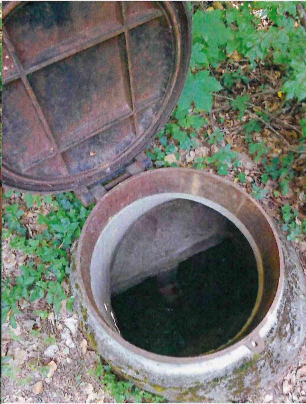
*Accès au-dessus du plan d'eau, non étanche, pas de filtre à air*
