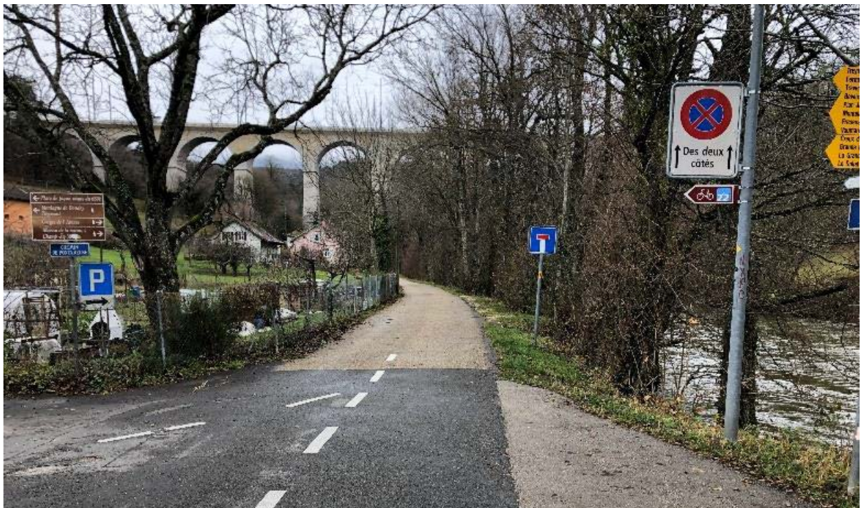
Berge rive droite actuelle à rehausser le long du chemin des Clées sur un linéaire d'environ 150 m selon proposition de mesure active
