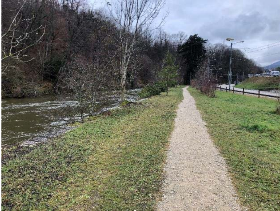
Prolongement du rehaussement du mur de berge en rive gauche à l'aval du pont de la route cantonale. Photo de l'état actuel (haut) et profil type (bas).
