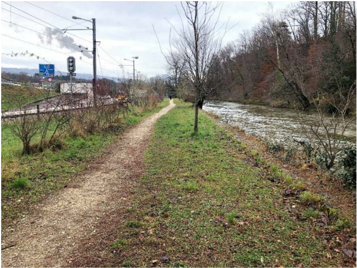
Mur de berge à créer en rive gauche à l'aval du pont de la route cantonale.
