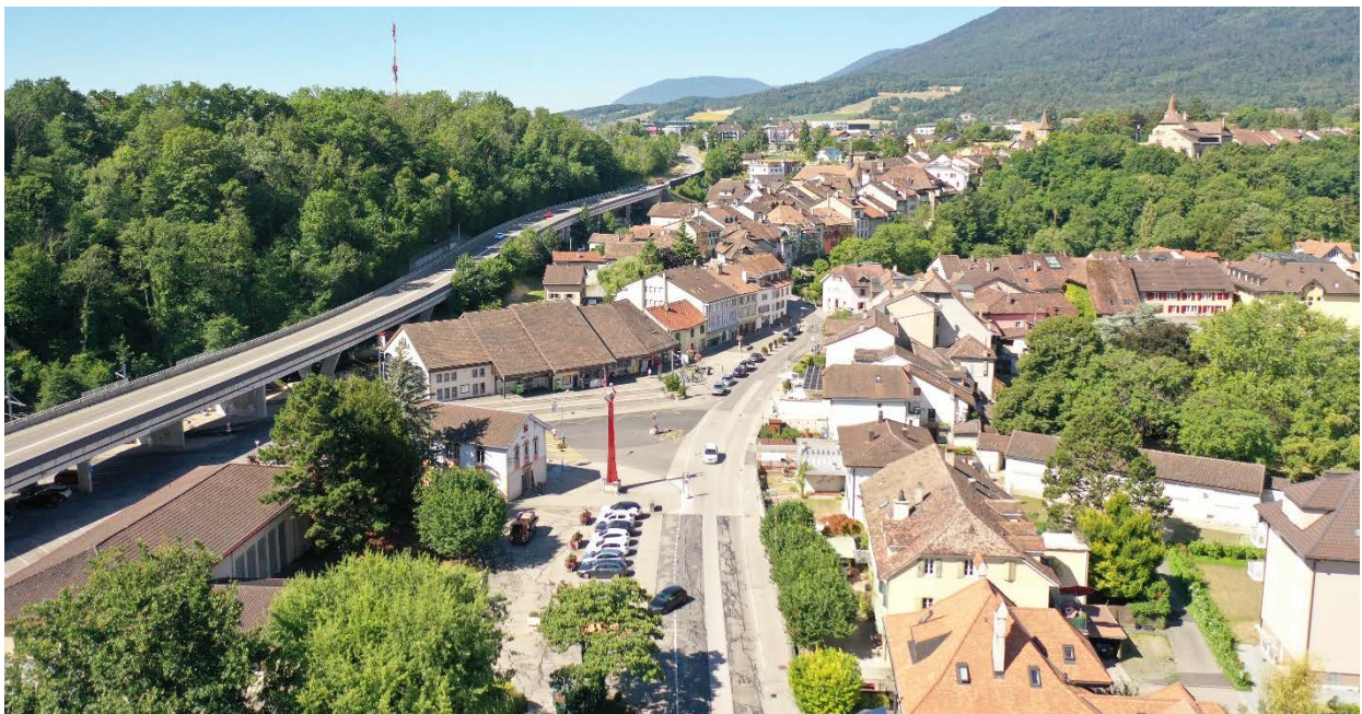
Figure 1 : vue sur Boudry (depuis l'avenue du Collège)
