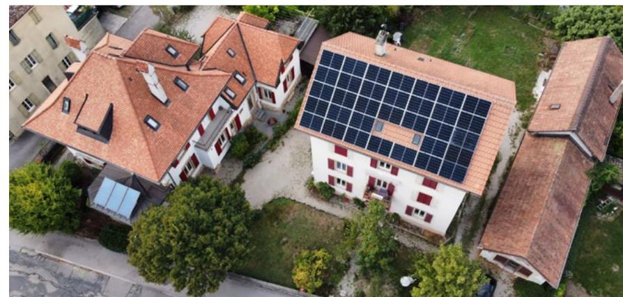
Vue aérienne d'une installation de 13,5 kilowatt crêtes (33 modules) pour 2 maisons câblées formant un RCP (regroupement de consommation propre) avec une seule introduction Eli10. Panneaux solaires thermiques de 7m<sup>2</sup> pour l'eau chaude sur la véranda.
