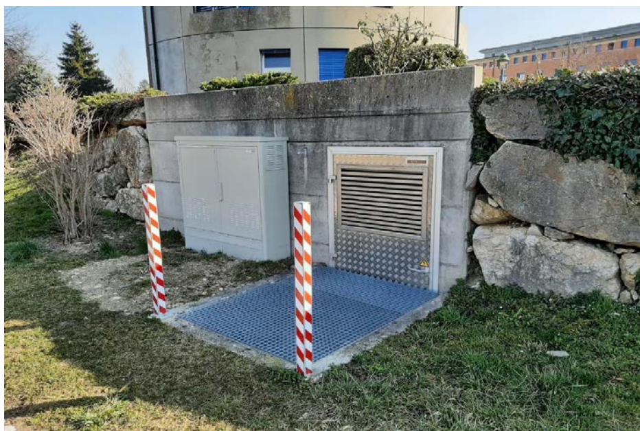
Figure 5 : Vue extérieure de la station « Buchilles »
