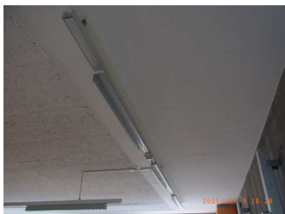
Nouveaux luminaires LED avec déflecteur pour le tableau noir et normal pour la classe
