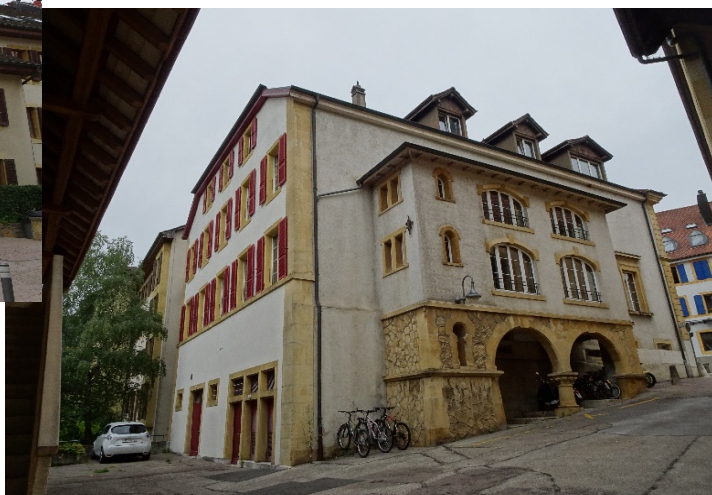
Façades Sud + Est
