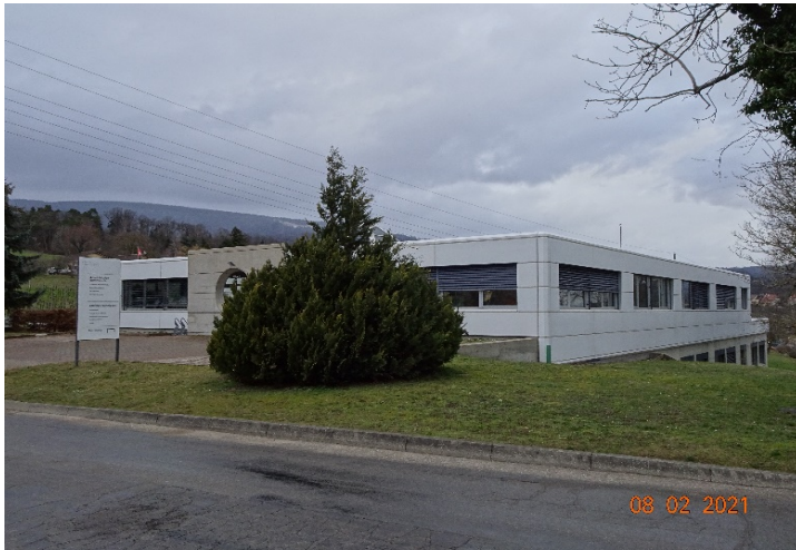
Façades Sud-Ouest + Sud-Est
