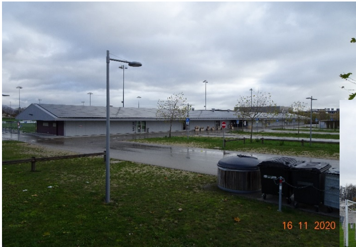
Façades Sud + ouest
