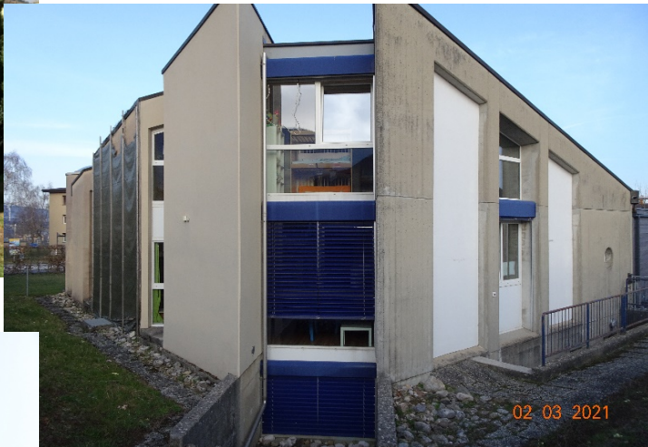
Façade Nord -Ouest + Sud-Ouest
