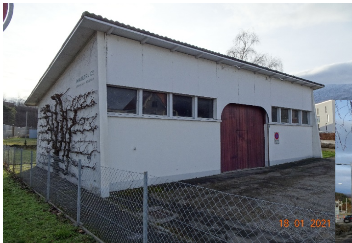
Façades Sud-Est + Nord-Est
