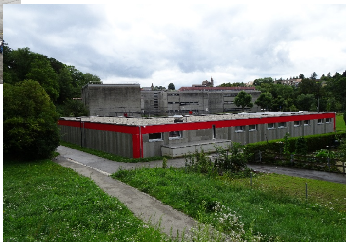
Façades Nord-Est + Nord-Ouest
