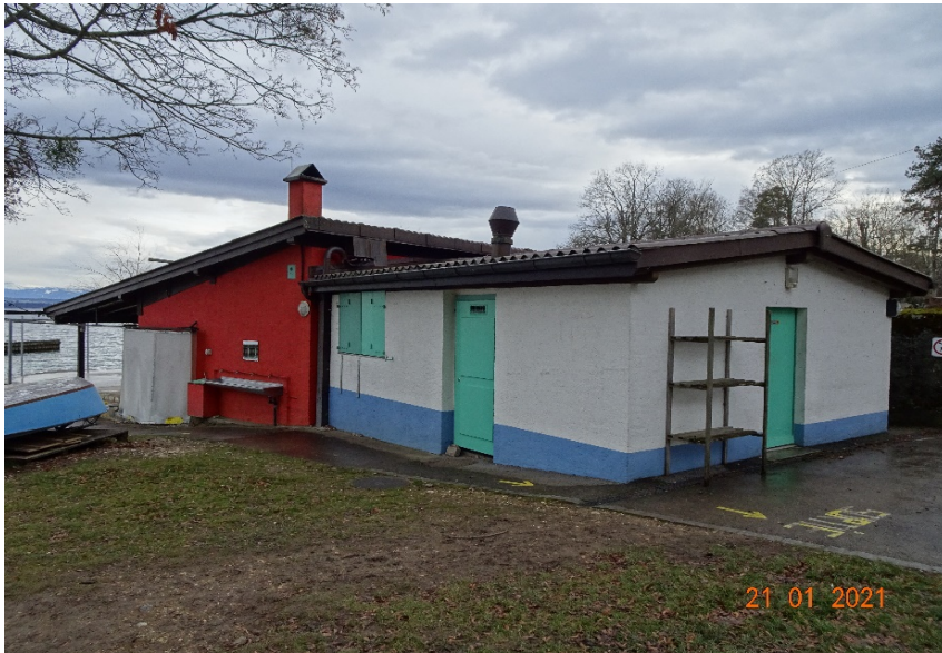
Façades Nord-Est + Nord-Ouest
