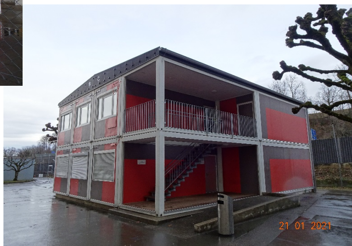
Façades Nord-Ouest + Sud-Ouest
