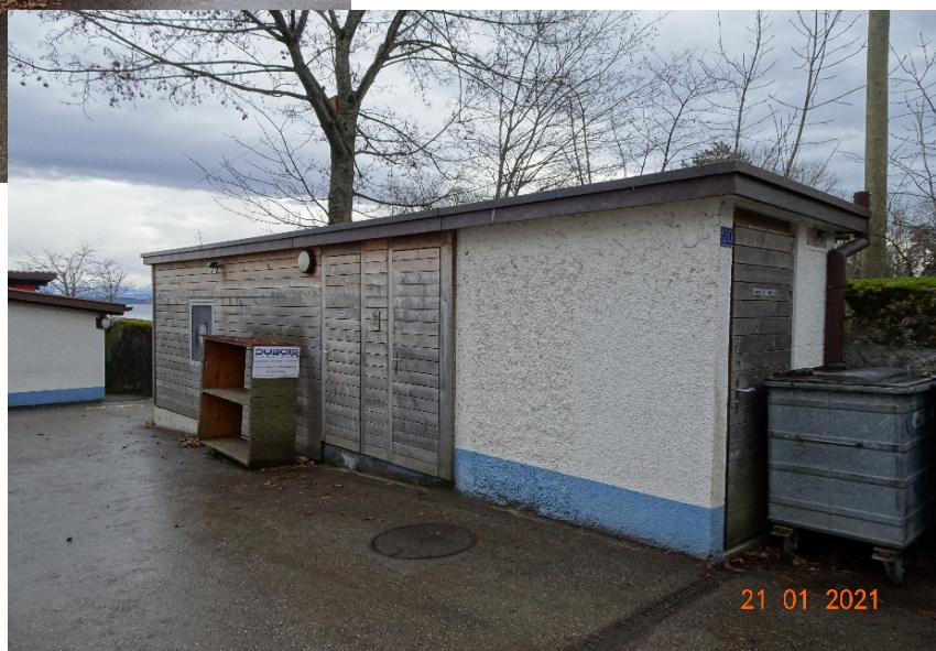
Façades Nord-Est + Nord-Ouest
