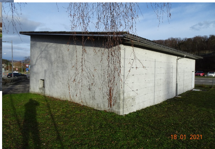
Façades Nord-Ouest + Sud-Ouest
