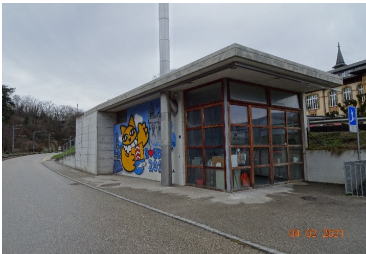
Façades Sud-Est + Nord-Est
