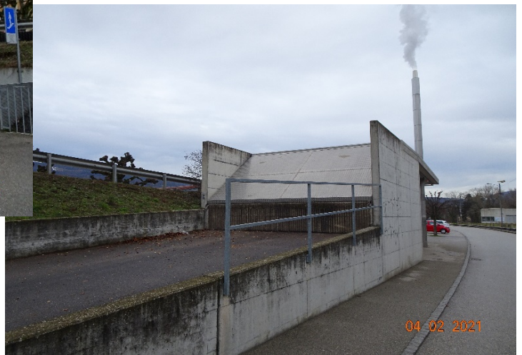
Façades Sud-Ouest + Sud-Est
