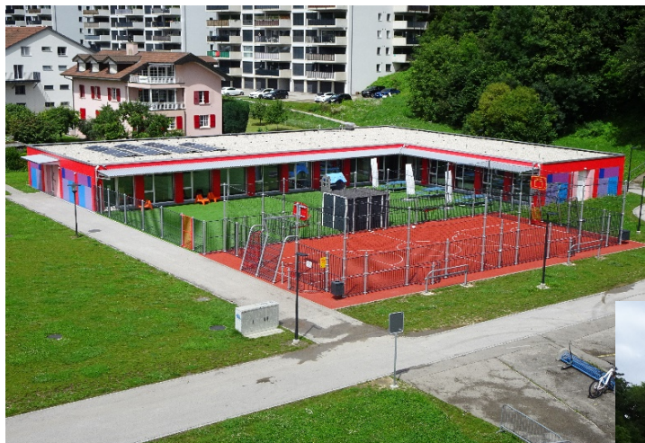
Façades Sud-Ouest +Sud-Est
