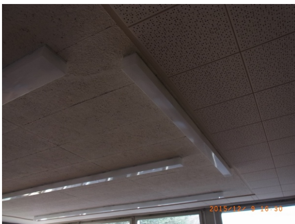
Anciens luminaires avec tubes fluorescents T8 et ballast ferromagnétique
