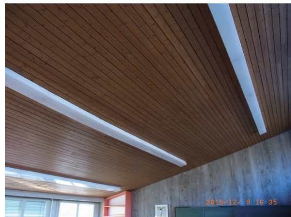
Anciens luminaires avec tubes fluorescents T8 et ballast ferromagnétique
