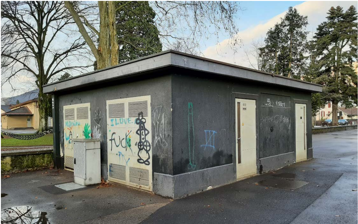
Figure 5 : Vue extérieure de la station « Collège »
