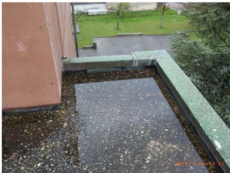
Dès lors, afin de décharger la toiture en favorisant l'évacuation de cette eau stagnante qui ne peut actuellement plus que disparaître par évaporation, il a été décidé, avec l'entreprise qui assure le contrôle de l'étanchéité, de créer, dans un premier temps et à titre provisoire, des dégorgeoirs comme illustré ci-dessous :
