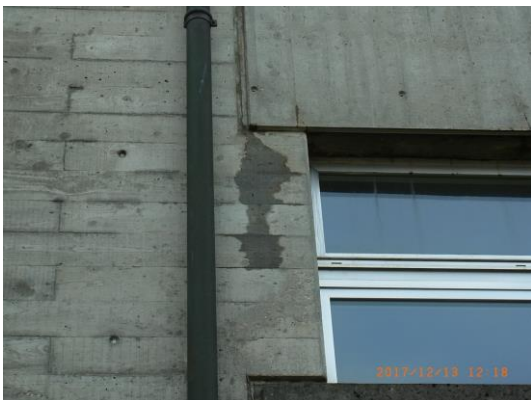
Diverses sorties d'eau en façade
