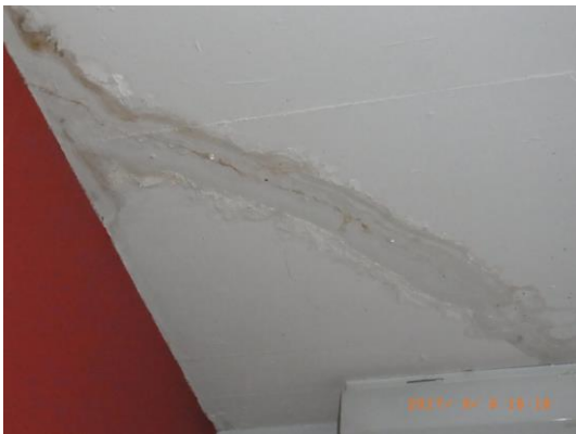
Plafond de la cage d'escalier
