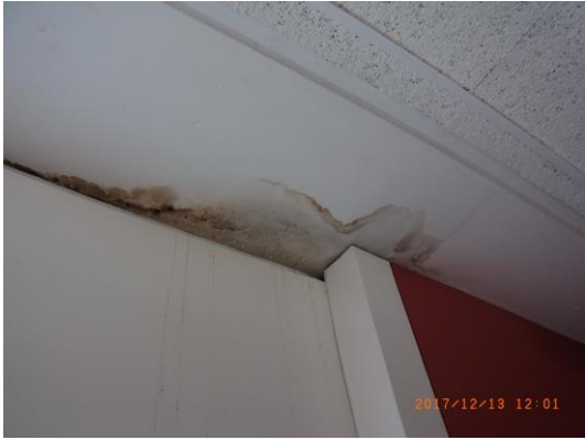
Intérieur du couloir à l'étage
