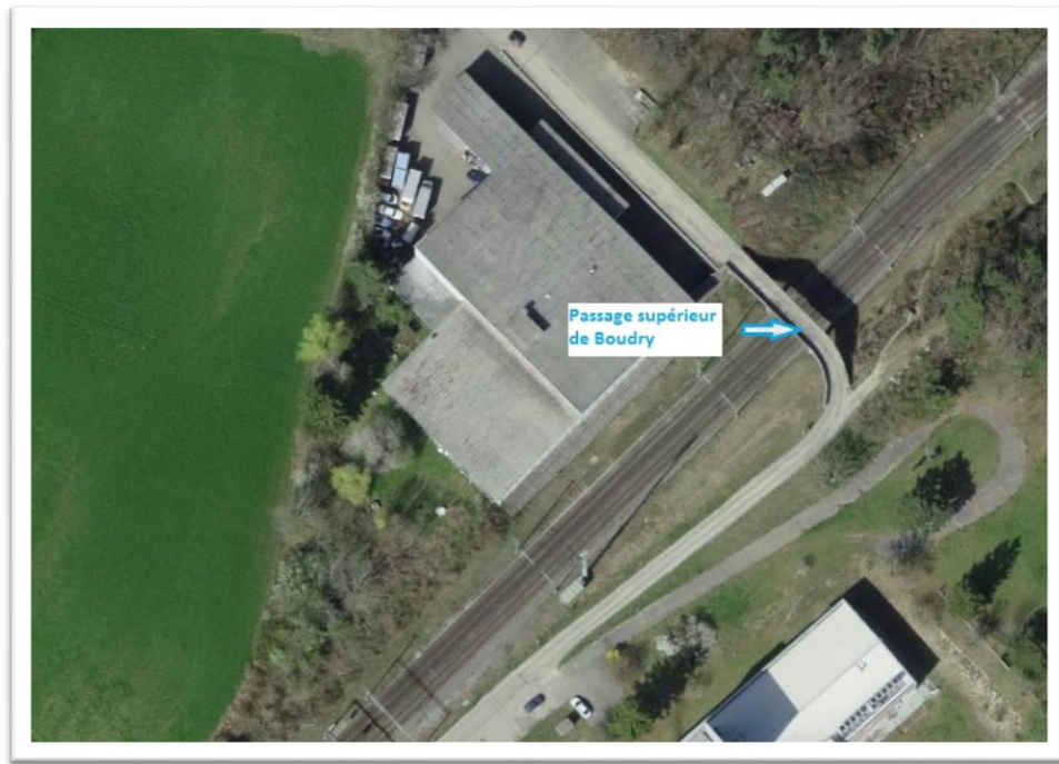
Figure1 : Situation actuelle du passage supérieur de Boudry
